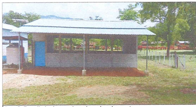
Foto 5: Repellado de pared y colocación de puerta
