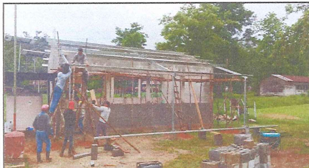
Foto 3: Colocación de costaneras para techo
