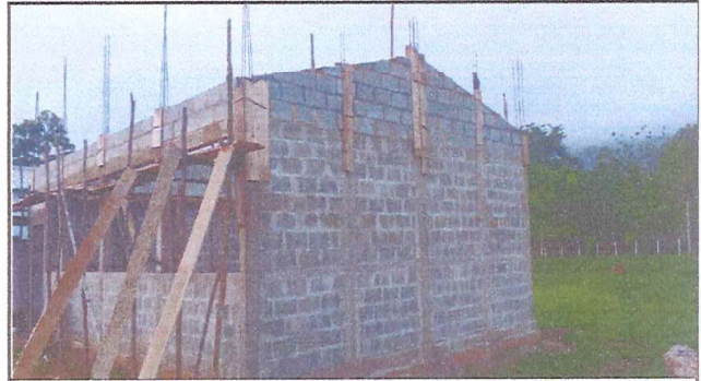
Foto 2: Construcción de fundición terminada
