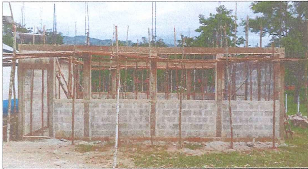
Foto 1: Coronando la construcción
