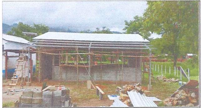
Foto 4: Colocación de techo
